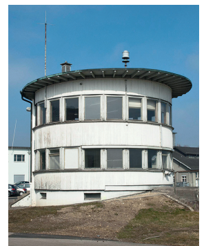
Oben: Bauzeitliches anthrazitfarbenes Erscheinungsbild des «Peil- und Startpavillons». Ansicht von Osten. Dok. 2. Unten: Der Kontrollturm erhielt 1954 einen weissen Anstrich. Ansicht von Südosten. Aufnahme November 2011. KDP Fotoarchiv.
