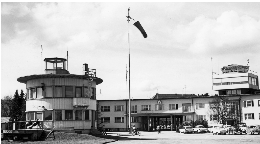
Alter und neuer Kontrollturm. Im Vordergrund steht der 1940 erbaute alte Kontrollturm mit der 1948 auf dem Dach errichteten Beobachtungskanzel. Auf dem Eingangsgebäude befindet sich der neue Kontrollturm von 1961. Dok. 2.
