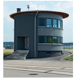
Der alte Kontrollturm erscheint dunkelgrau. Ansicht von Westen. Zustand nach der Renovation, Mai 2013. KDP Fotoarchiv.
