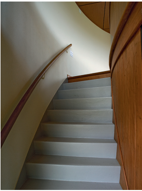
Geschwungener Treppenaufgang vom Erdgeschoss ins Obergeschoss. Aufnahme Mai 2013. KDP Fotoarchiv.
